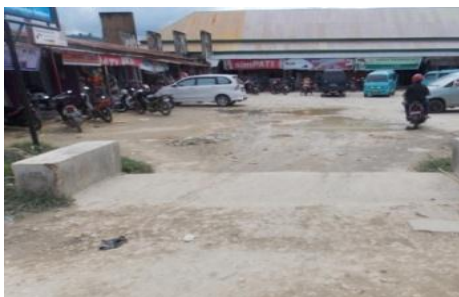
Gambar 5. Kondisi Guna Lahan Pasar
