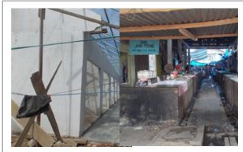
Gambar 1. Kondisi Fisik Bangunan Pasar Boepinang
