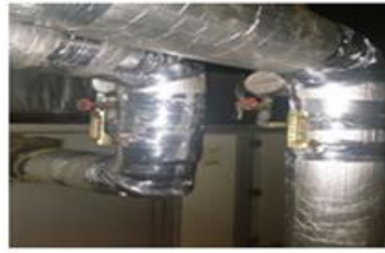
Gambar 7. Perbaikan Jacket dari Chiller
