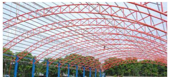
Gambar 5. Struktur Rangka Atap Baja Konvensional Sumber: alamsakti.com
