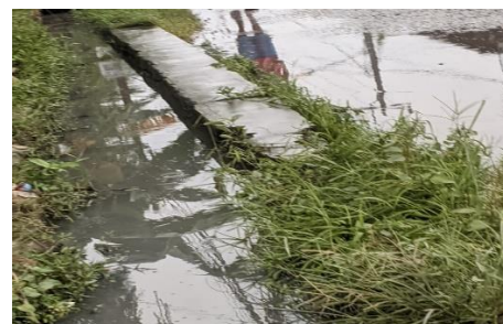
Gambar 3. Permasalahan Kerusakan Perkerasan pada Jalan Raya (Dokumentasi Pribadi, 2023)
