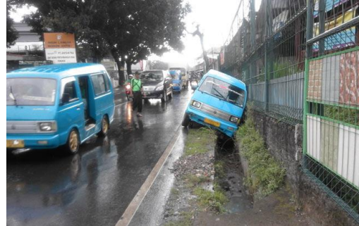
Gambar 5. Permasalahan Kecelakaan Lalu Lintas pada Drainase Jalan Raya (Bogordaily, 2023)
