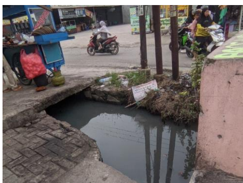
Gambar 7. Dokumentasi Sistem Drainase Jalan Raya Model Terbuka (Dokumentasi Pribadi, 2023)
