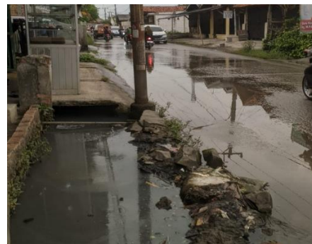
Gambar 2. Permasalahan Genangan Air Hujan pada Jalan Raya di Cikarang Utara (Dokumentasi Pribadi, 2023)
