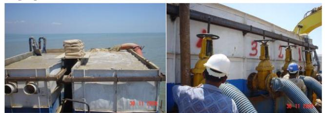
**Gambar 5. Slurry bentonite untuk stabilizer dinding tiang bor**
