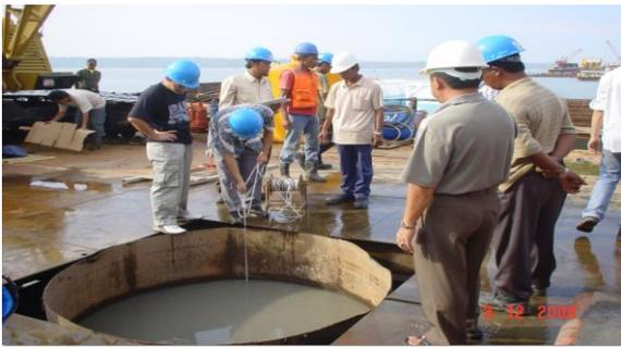
Gambar.9 Pengukuran Kedalaman Pengeboran
