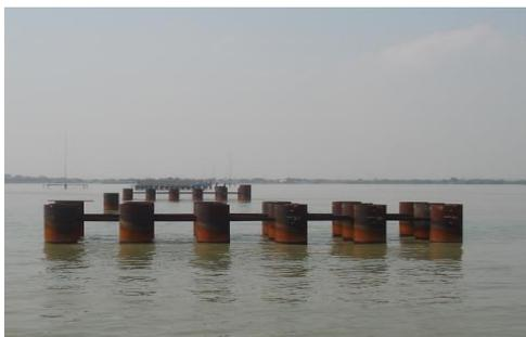
Tahap kedua adalah pembuatan temporary platform untuk berdirinya unit *Reverse Circulation Drilling (RCD)*, *excavator*, *service crane*, serta *tools & accessories* pendukung.(Gambar 3.)
