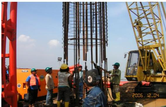
Gambar 10. Sambungan besi dengan mekanikal coupler
