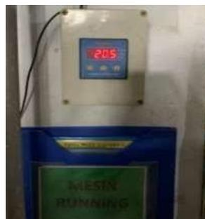
Gambar 6 Alat Ukur Otomatis Jababeka Pada Saat Proses Kondaktivitas Proses Demineralisasi Saat Backwashing Regenerasi
