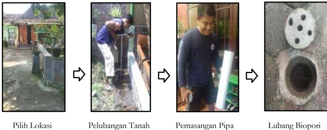
Gambar 5 Proses Pembuatan Lubang Resap Biopori
