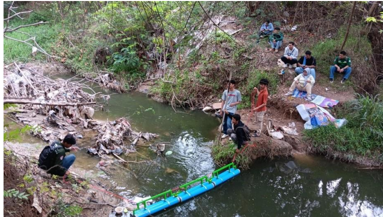
Gambar 7. Pemasangan Alat Perangkap Sampah di Sungai
