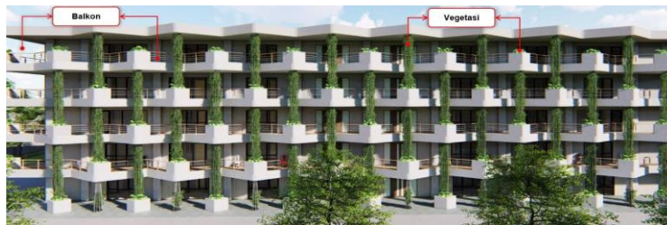
Gambar 7. Fasad Rumah Susun Kota Madiun
