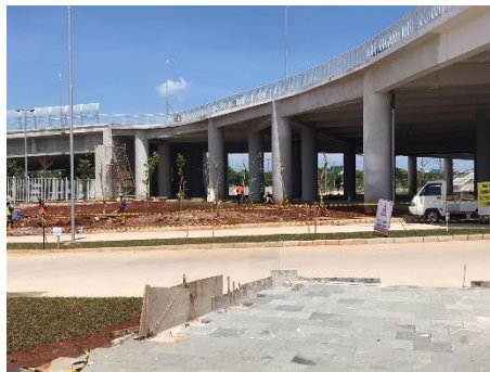
Gambar 4. Material pada Hardscape adalah Cor Beton dan Batu Alam pada Rancangan Lanskap Jakarta International Stadium
