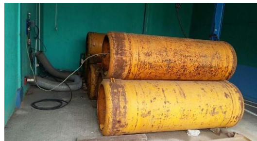
Gambar 2.1 Tempat Penyimpanan Gas Klor WTP I PT. Jababeka Infrastruktur
