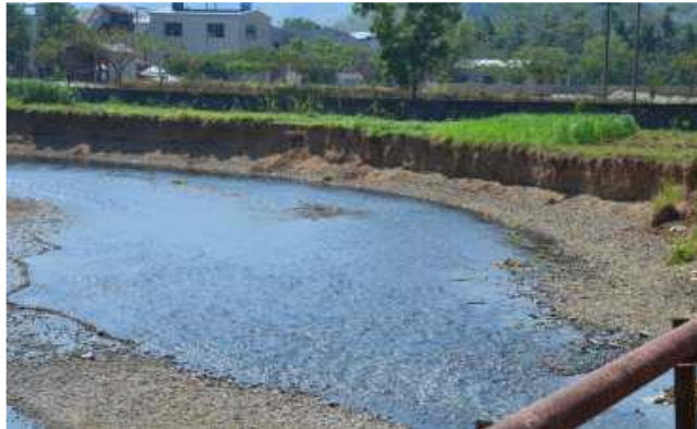
Gambar 3.15. Erosi dan Sedimentasi Sungai Grindulu di Desa Pagutan, Kecamatan Arjosari Sumber: Dokumentasi Penelitian Tanggal 18 Agustus 2014
